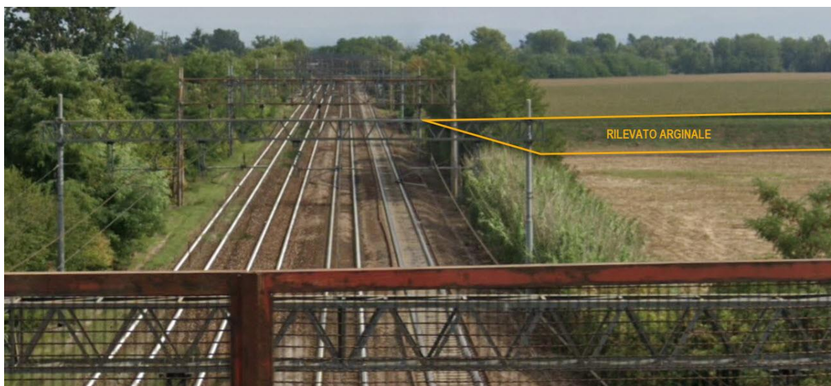
Intersezione tra rilevato ferrovia Torino- Genova e rilevato arginale
